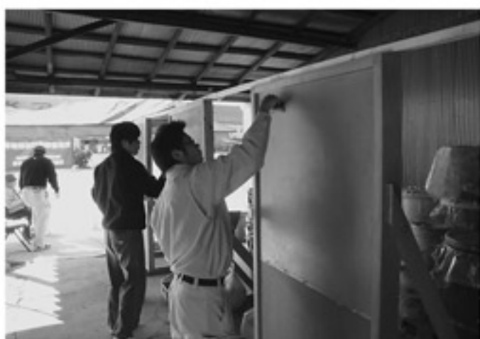
色々な色の大津壁塗り
