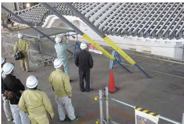
姫路城大天守修理現場見学
