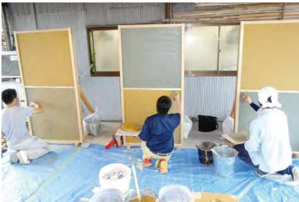
大津壁塗り実技
