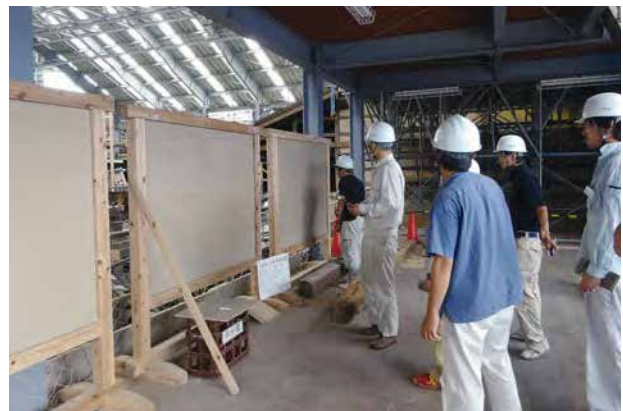
勝興寺修理現場見学
