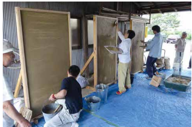
大津壁塗り実技
