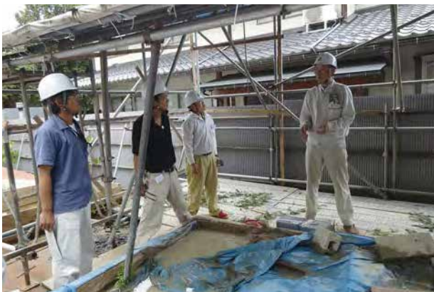
勝興寺修理現場見学
