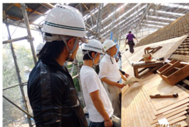
修理現場見学
