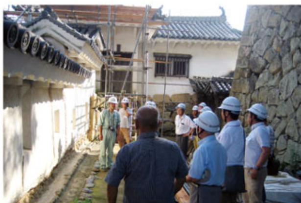
姫路城修理現場
