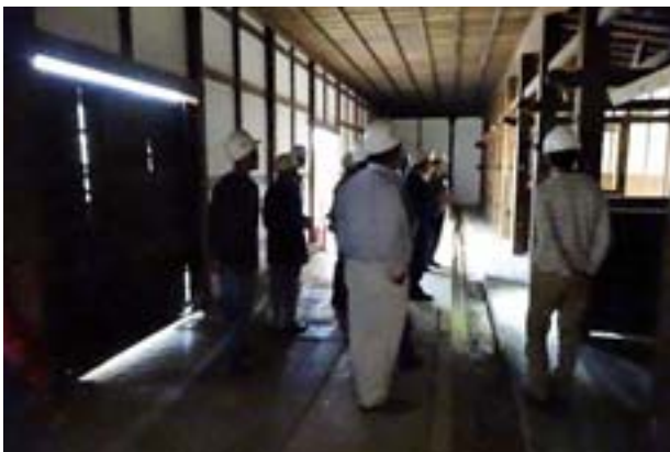
彦根城馬屋修理現場見学
