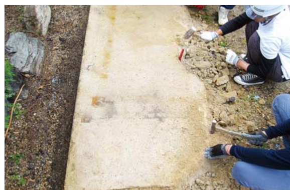
土間三和土 解体
