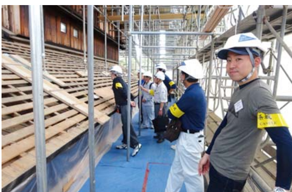
二条城修理現場見学
