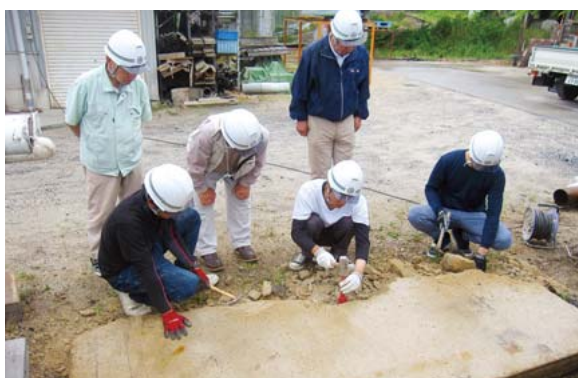
土間三和土 解体
