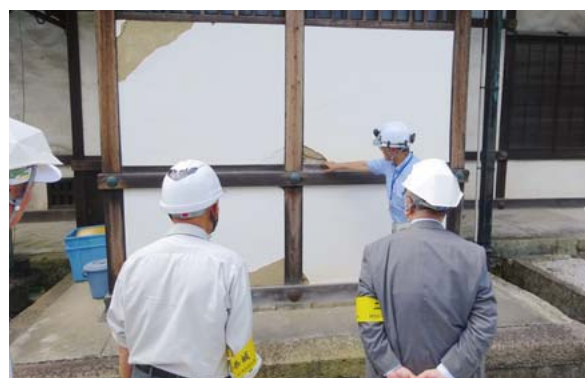
二条城修理現場見学
