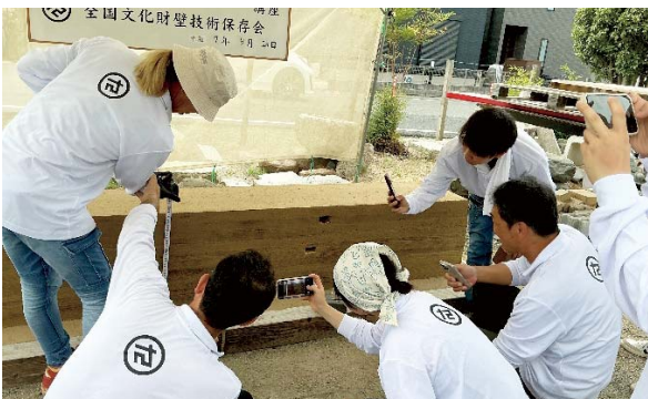
型枠を外して仕上がり検査
