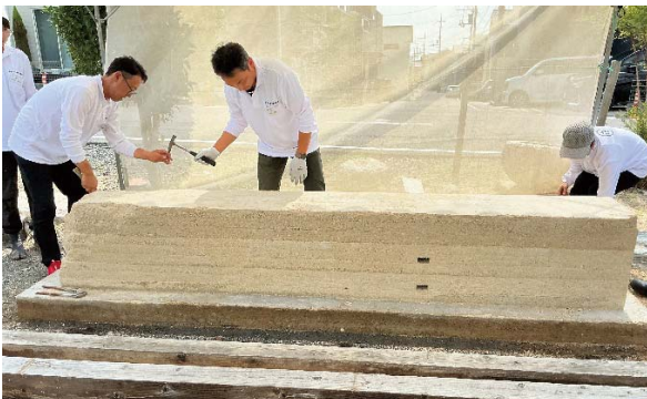
昨年度研修生の版築を解体調査
