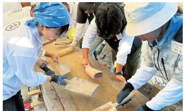
津田副会長指導のもと版築施工
