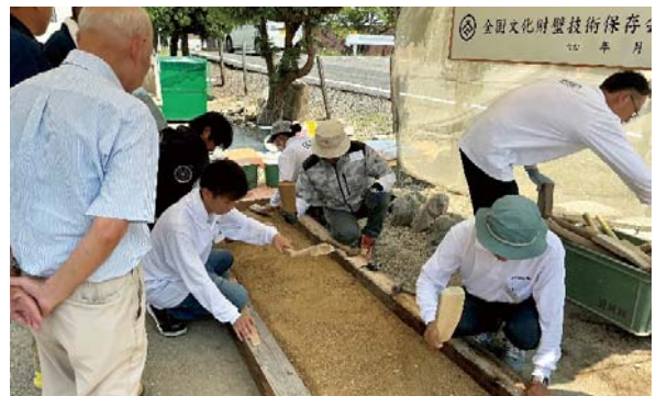
土間三和土の実技研修
